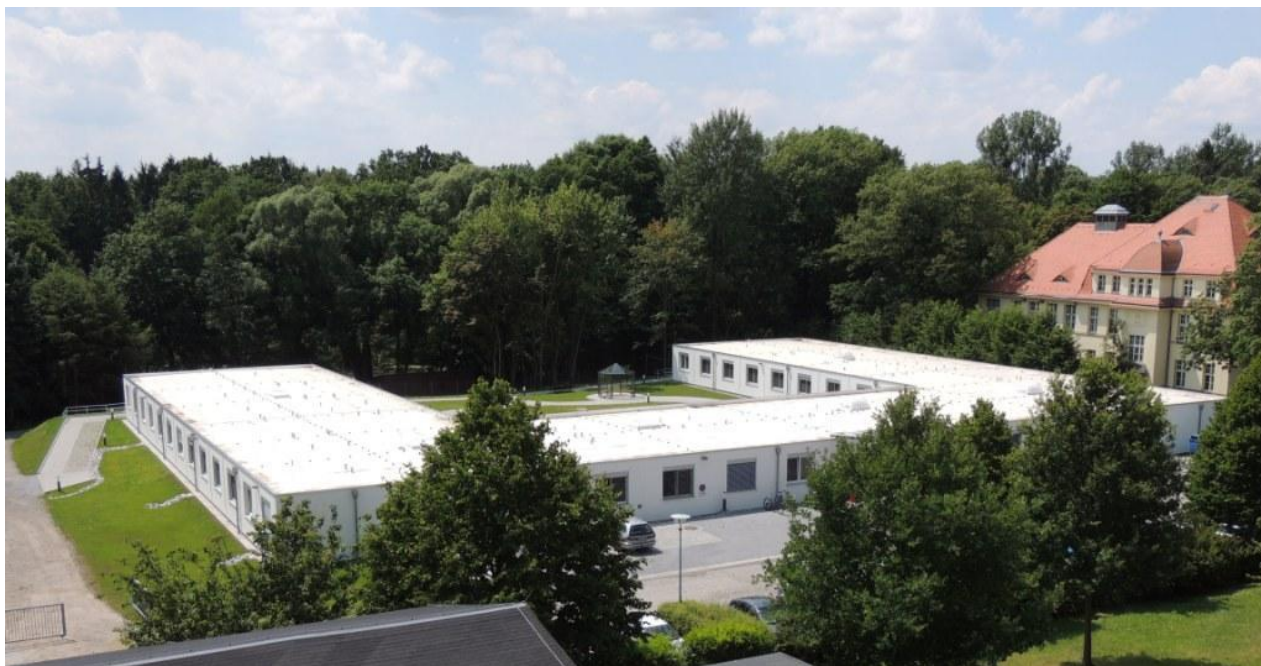
Gerontopsychiatrie im neuen Modulgebäude B12
