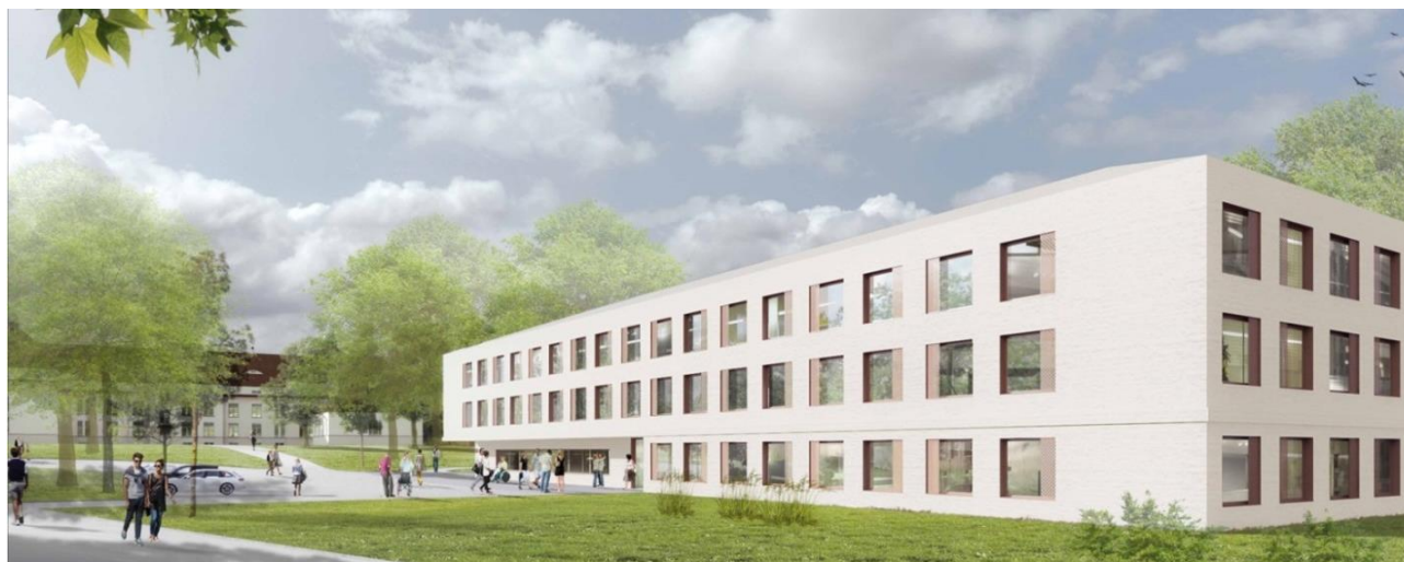
Im Bau befindliches Gebäude B4N
