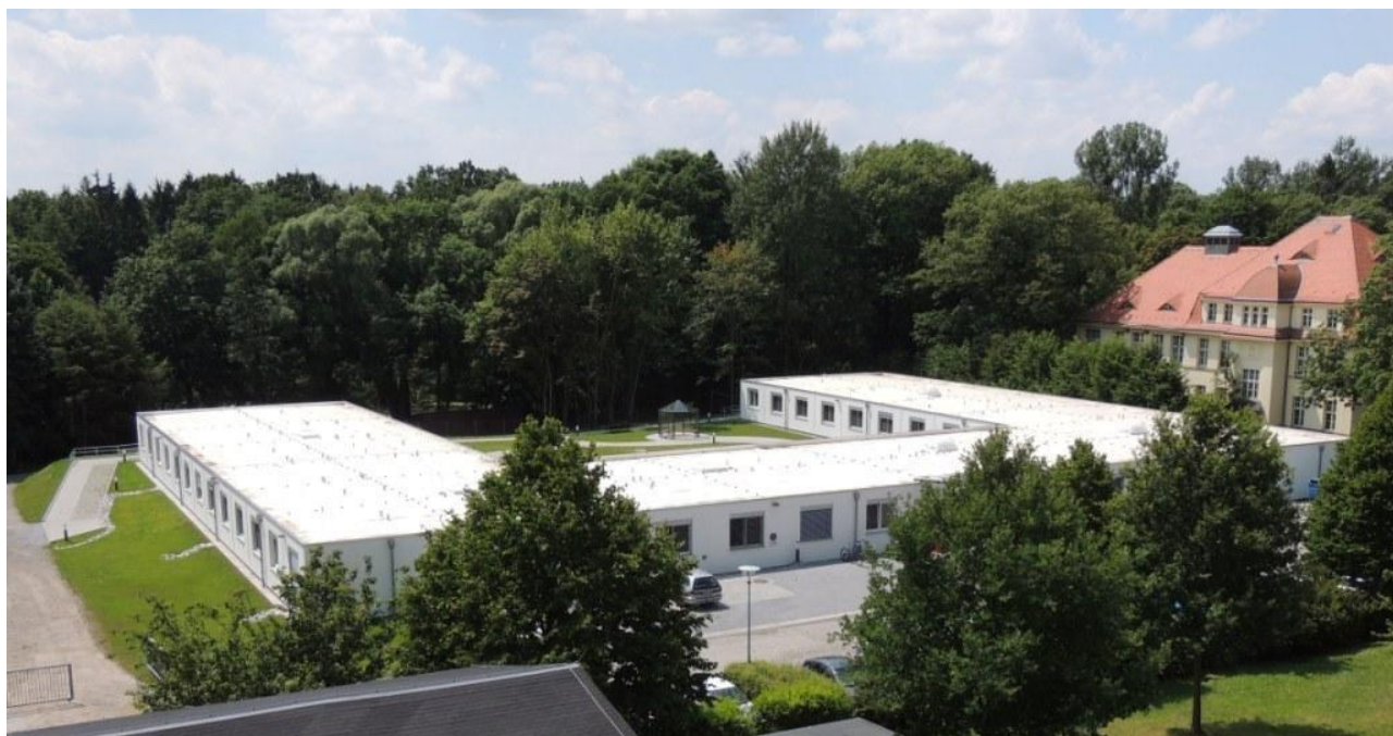
Gerontopsychiatrie, im neuen Modulgebäude B12
